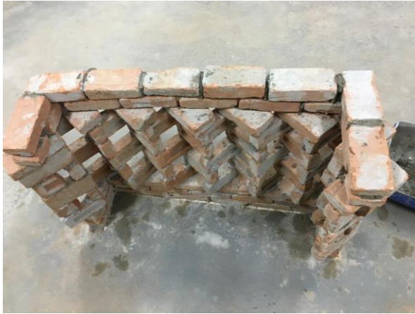
Figura 2 Muro de tijolos - Exercício de alvenaria.
