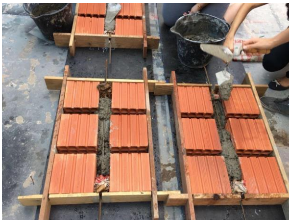
Figura 3 Montagem de painéis de cerâmica armada
