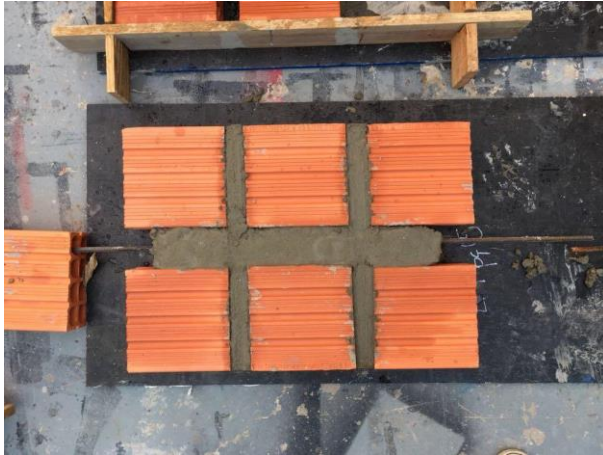
Figura 4 Montagem de painéis de cerâmica armada
