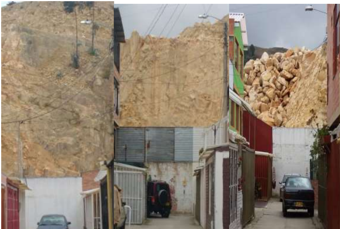
Figura 19. Calles urbanas aledañas a la cantera. Fuente: elaboración propia.
