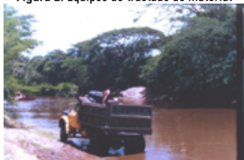
Figura 2. Equipos de traslado de material
