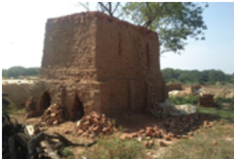
Figura 5. Horno tipo pampa para la cocción del ladrillo
