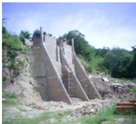
Figura 4. Adecuación de los nuevos hornos en la nueva planta Hornical
