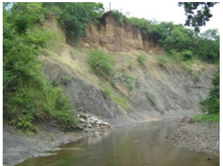
Figura 8. Deslizamiento producto de movimientos de remoción en masa
